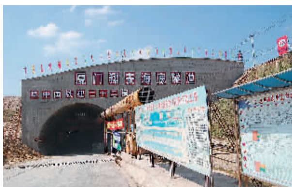
二十二局集团参与施工的厦门翔安海底隧道,是我国大陆地区第一条海底隧道。
