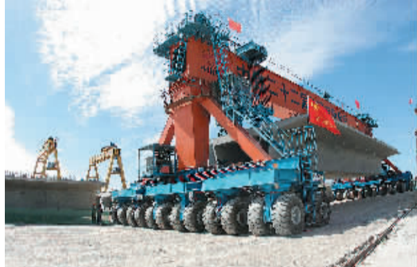
京津城际铁路最大制梁场900吨搬运机搬运箱梁。
